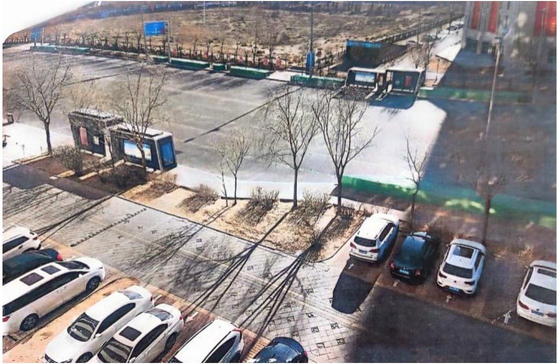
图 2 高新区新能源智慧公交建设工程现场图
