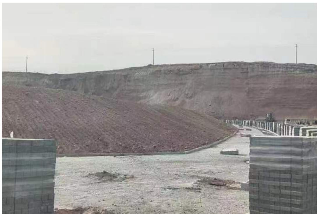
图 4 鄂尔多斯市东胜区罕台镇羊绒产业片区经二路等三条道路经二路道路管网 工程施工图片
