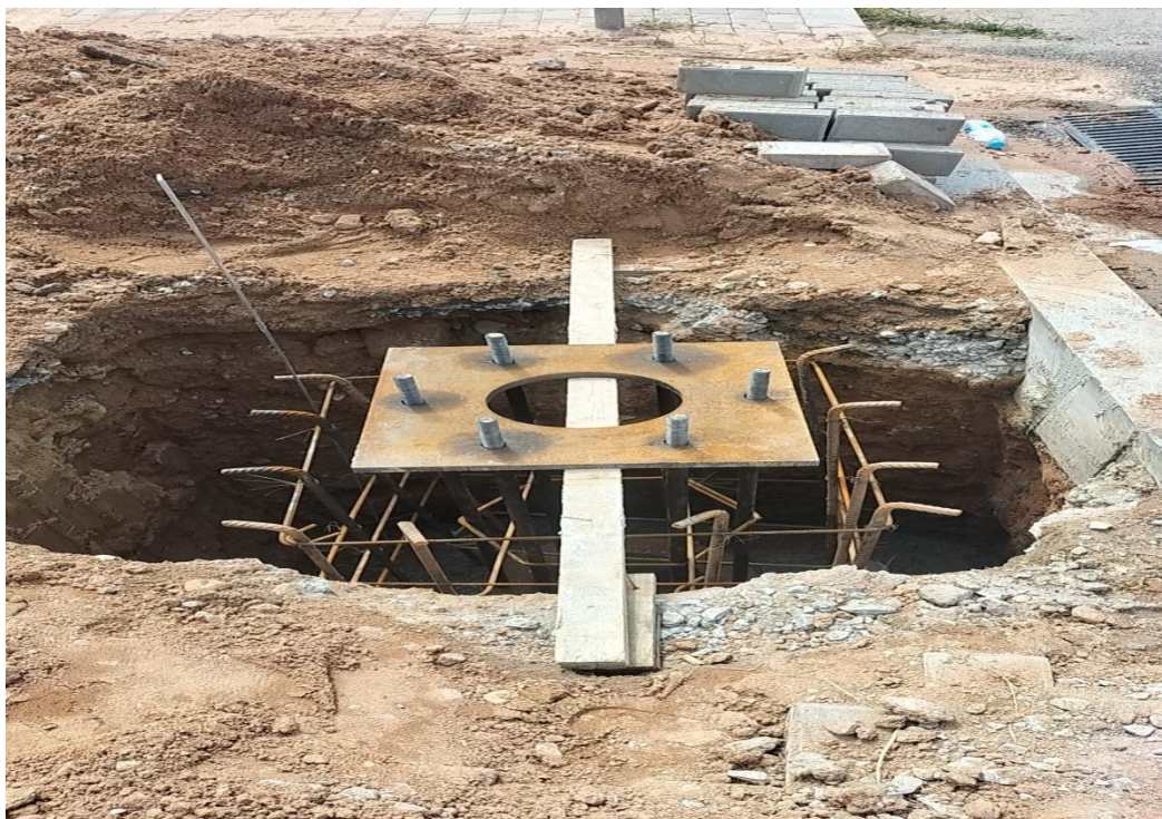
图 1 轻纺产业园罕台十二路（九成宫路~经四路）道路照明工程施工图片
