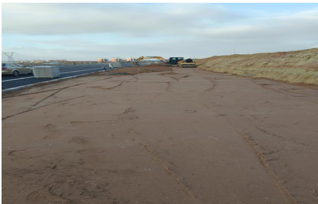
图 3 鄂尔多斯市东胜区罕台镇羊绒产业片区经二路等三条道路经二路道路管网 工程施工图片
