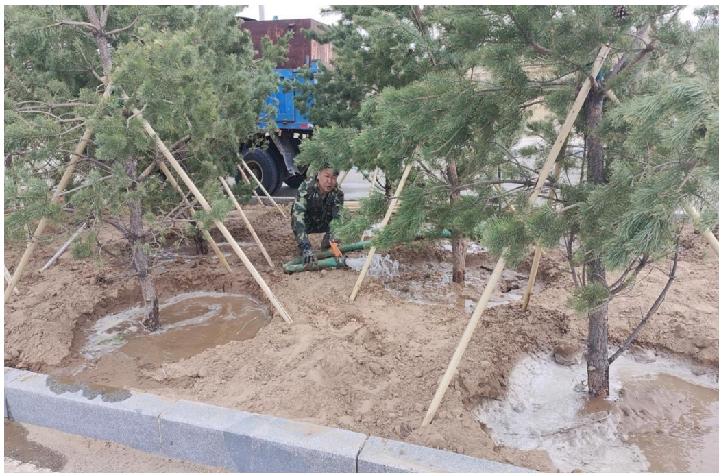
图 2 轻纺产业园罕台十二路（旅游专线~经五路）中央隔离带绿化工程施工图片
